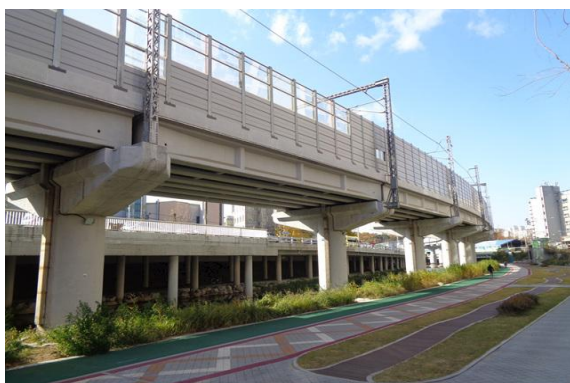
방음벽 외측(내선) 전경
