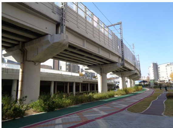
PSC 거더 전경
