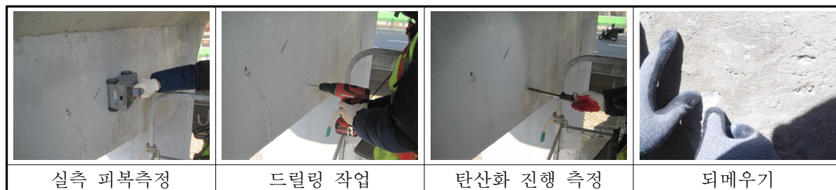
【그림 II-1.3.24】 탄산화 깊이 측정 절차
